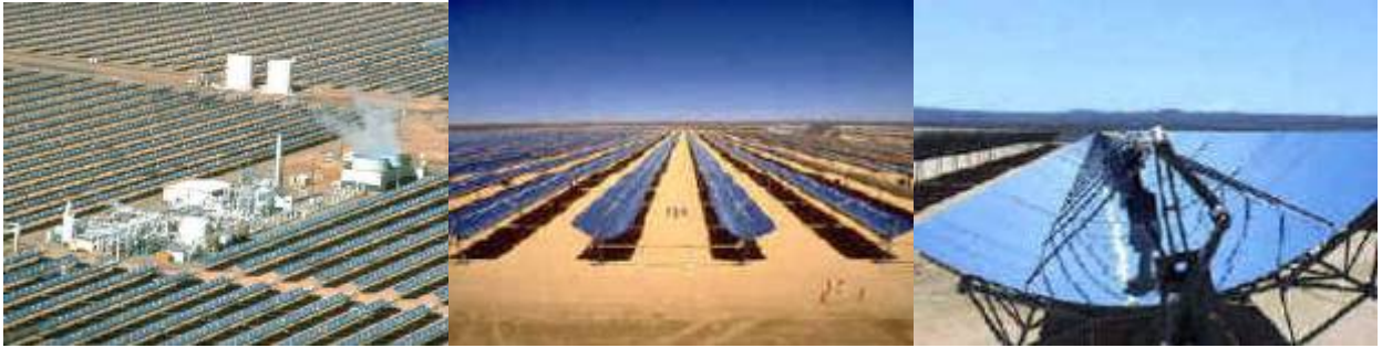
Capteurs cylindro-paraboliques (centrale solaire de Kramer Junction en Californie)
