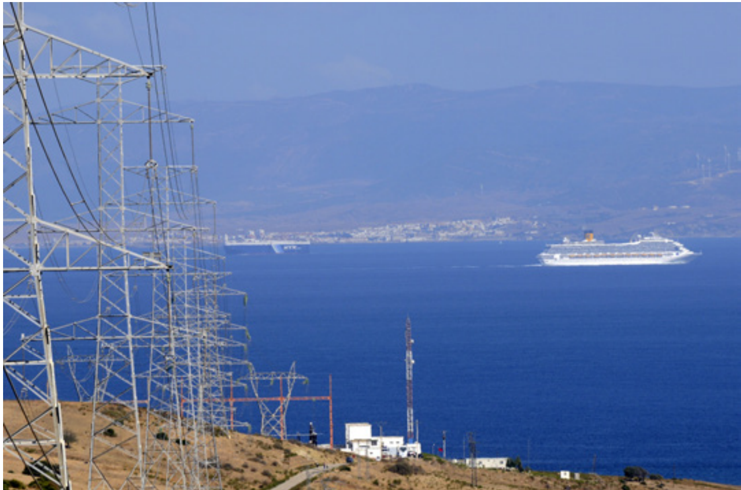
Poste interconnexion Maroc - Espagne
