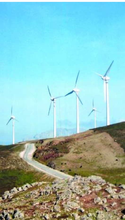
Parc éolien modèle de l'ONE de 3,5 MW
