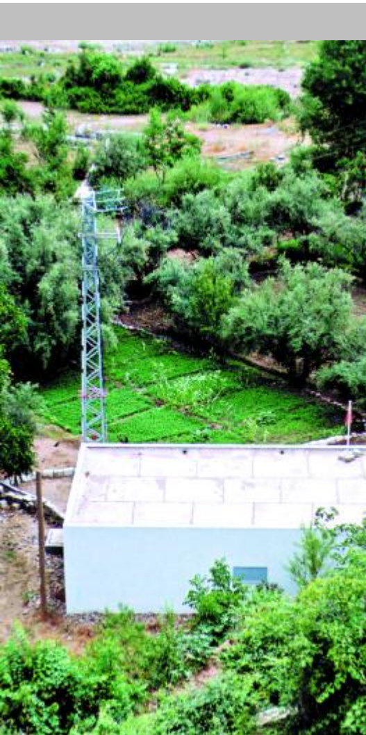
La micro centrale hydraulique d'Askaw dans la Province de Taroudant
