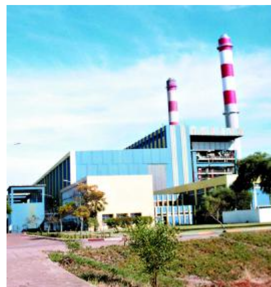
Centrale thermique de Kénitra
