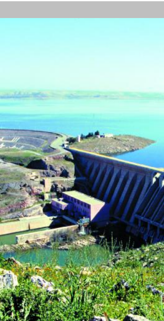
Barrage d'Al Massira
