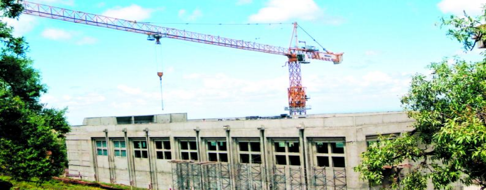
Chantier de la Centrale à Cycle Combiné de Tahaddart
