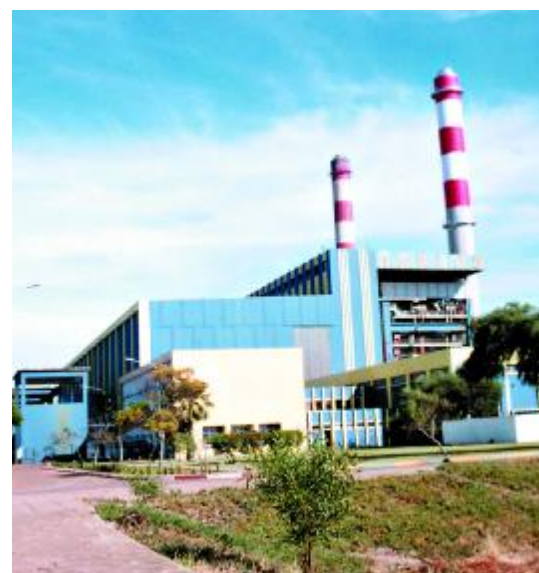
Centrale thermique de Kénitra
