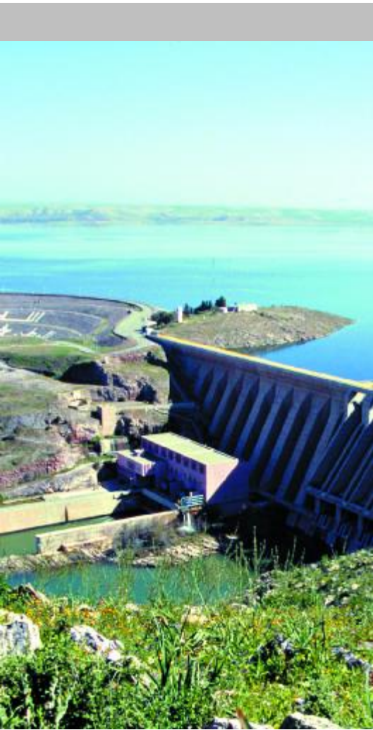
Barrage d'Al Massira
