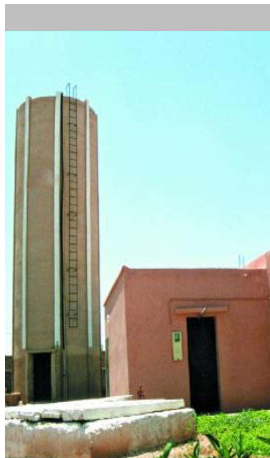
Pompage industriel de l'eau dans la province d'El Haouz
